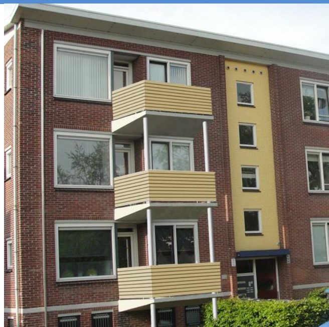
Gesloten balustrade, afgestemd op luifel
