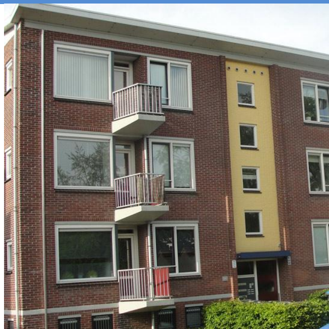
Balkons voorzijde, huidige situatie
