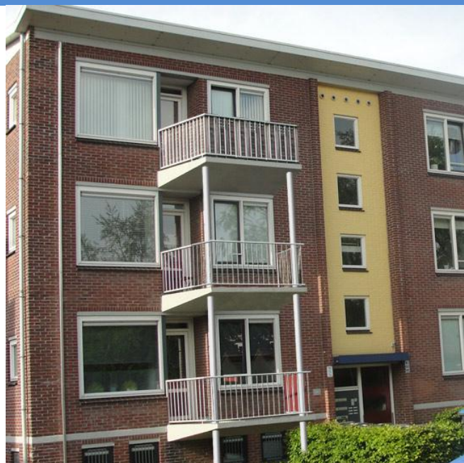
Na renovatie, zelfde type balustrade (open)
